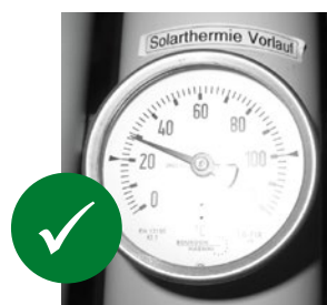
[FIG. 40] Utiliser un thermomètre dont l'entretoise est suffisamment longue.
