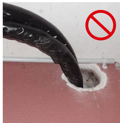
[FIG. 35] Traversée non obturée entre l'extérieur et la cave.
