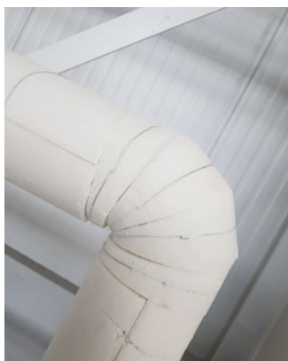
[FIG. 10] Isolation d'un coude au moyen de segments de demi-coques en PIR.
